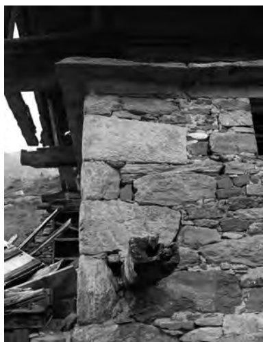
Stubbi Particolare della cantonale Détail d'une chaîne d'angle Detail eines Verbindungsankers an der Hausecke
