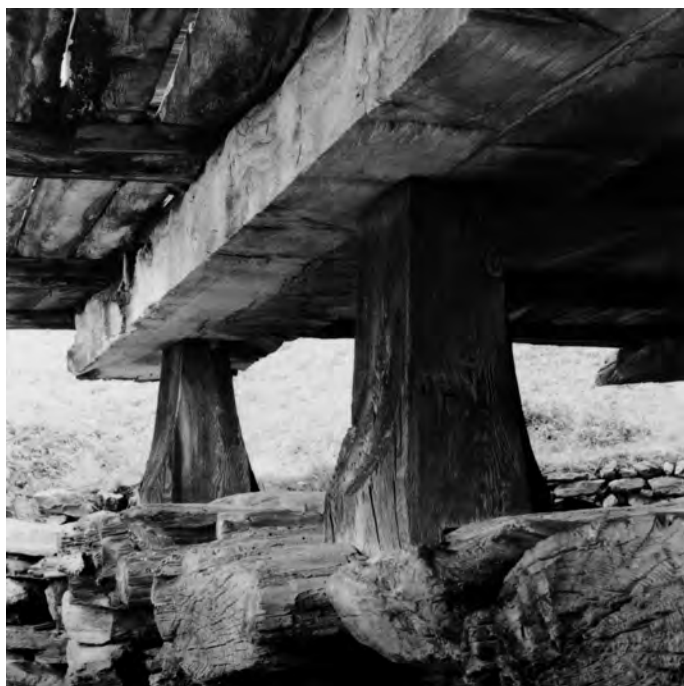
Rong (sopra Ésschleio), Saint-Jean, 1523-30 Pilastrini senza disco Plot sans dalle de pierre Pfeiler ohne Steinplatte
