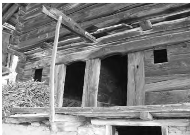
Bech Porte gemelle nel piano di abitazione Portes jumelles à l'étage du logis Zwillingstüren im Wohnungsgeschoss
