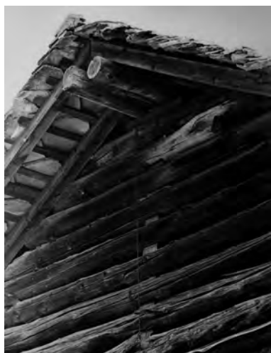
Lommatò, Saint-Jean Struttura lignea di tipo medievale, con "spina" Structure en bois avec "aiguille". Type médiéval Holzstruktur mit „Nadel“. Mittelalterlicher Typ
