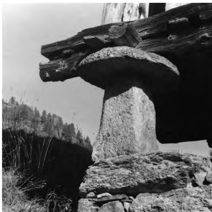
Bühl Pilastrino in pietra sul lato verso monte Plot en pierre à l'amont Steinpfeiler auf der bergwärts gerichteten Seite
